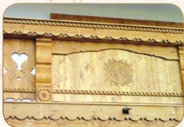
Garde corps type "tenon mortaise", poteaux 90 x 90, panneau 3 plis 19 mm avec rosace Ø 450 mm entre lisses 90 x 70, semelle sous la main courante 90 x 27 et la main courante 145 x 45 ou 155 x 55 mm.
