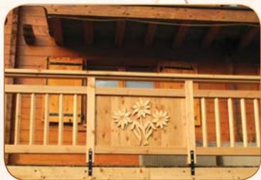
Garde corps type "tenon mortaise", poteaux 90 x 90, croisillons à 45° entre lisses 90 x 70, semelle sous la main courante 90 x 27 et la main courante 145 x 45 ou 155 x 55 mm.
