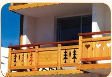
Garde corps type "tenon mortaise", poteaux 90 x 90, verre feuilleté entre lisses 90 x 70, semelle sous la main courante 90 x 27 et la main courante 145 x 45 ou 155 x 55 mm.
