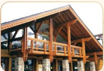
Garde corps type "tenon mortaise", poteaux 90 x 90, paline droite entre lisses 90 x 70, semelle sous la main courante 90 x 27 et la main courante 145 x 45 ou 155 x 55 mm.
