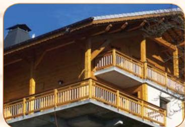
Garde corps type "tenon mortaise", poteaux 90 x 90, paline entre lisses 90 x 70, semelle sous la main courante 90 x 27 et la main courante 145 x 45 ou 155 x 55 mm.
