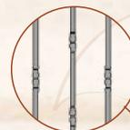
Garde corps type "tenon mortaise", poteaux 90 x 90, barreaux métalliques entre lisses 90 x 70, semelle sous la main courante 90 x 27 et la main courante 145 x 45 ou 155 x 55 mm.
