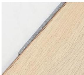
**Étape 1** : Mettez de la pâte de garnissage BerryAlloc Fillertwine dans le joint de dilatation (8-10mm). Il permet au stratifié de dilater/rétracter. Utilisez-le également dans le joint sous les profils de finition comme les barres de jonction, barres de seuil,...
