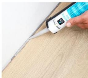
**Étape 2** : Mettez le mastic HydroPlus Sealant sur la pâte de garnissage Fillertwine. Le mastic doit toucher le mur et le sol et être appliqué de façon à colmater entièrement le joint. Avec des profils de dilatation, utilisez le mastic sur le Fillertwine avant d'installer le profil, pour éviter le contact d'eau avec la base du stratifié.
