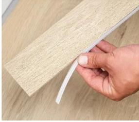
**Étape 3** : Collez la bande HydroPlus Strip à la base de la plinthe. Cette bande protège votre plinthe de l'humidité, tout en permettant au stratifié de se dilater/rétracter.
