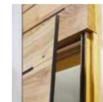
Une **bande magnétique** bloque la porte en position fermée et la jointe hermétiquement.
