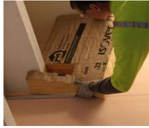
4 POSE DE L'ISOLATION
