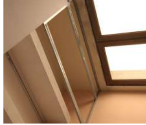
3 VUE DE L'OSSATURE (SANS ISOLANT)
