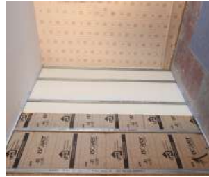
5 POSE D'UNE FOURRURE D'ANGLE
