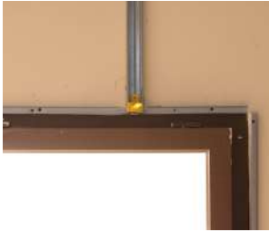
3 FIXATION DE FOURRURES ET DES APPUIS OPTIMAZ
