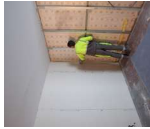
6 POSE D'UNE LISSE D'ANGLE
