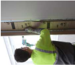
③ VISSAGE LISSE D'ANGLE
