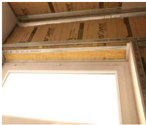
8 VUE DE L'OSSATURE DE TABLEAU
