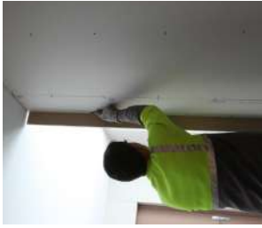
④ DÉCOUPE PAREMENT SUR L'ANGLE
