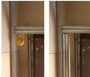
7 POSE D'UN CONNECTOR HAUT POUR ANGLE DROIT
