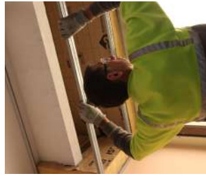
6 RÉGLAGE DE LA FOURRURE D'ARÊTE
