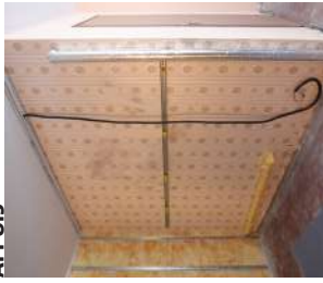
3 POSE DES FOURRURES HORIZONTALES ET APPUIS
