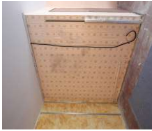
2 POSE DES LISSES CLIP'OPTIMA
