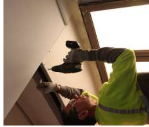
7 POSE DU PAREMENT SOUS FACE
