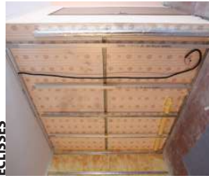
6 OSSATURE AVANT PROLONGEMENT DES ÉCLISSES
