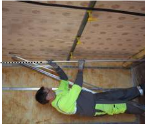
4 POSE DES FOURRURES VERTICALES
