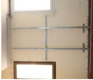
7 PLAN DE L'OSSATURE (VUE SANS ISOLANT)
