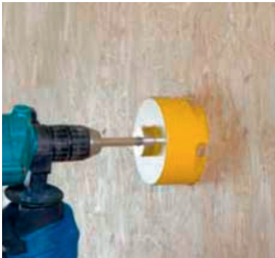
Perçage d'une ouverture circulaire
