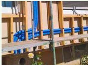
Il peut être insufflé entre les poutres en I STEICO, afin d'optimiser le rendement énergétique de la construction.
